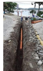
Obra Av. José Bento
